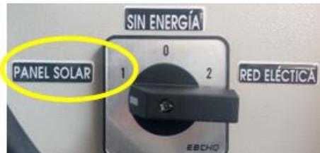
**Ilustración 4-11:** Transferencia manual en panel solar
