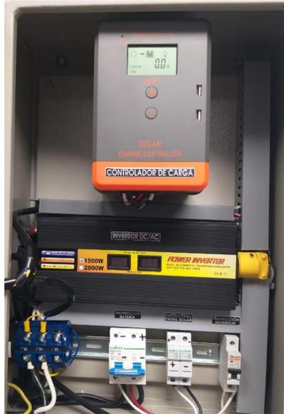
**Ilustración 3-14:** Montaje en tablero eléctrico
