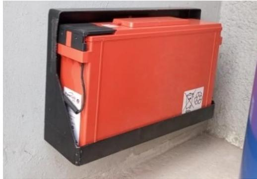
**Ilustración 3-10:** Anclaje de la batería
