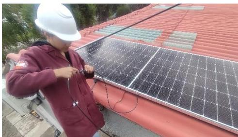
**Ilustración 4-4:** Instalación del panel solar
