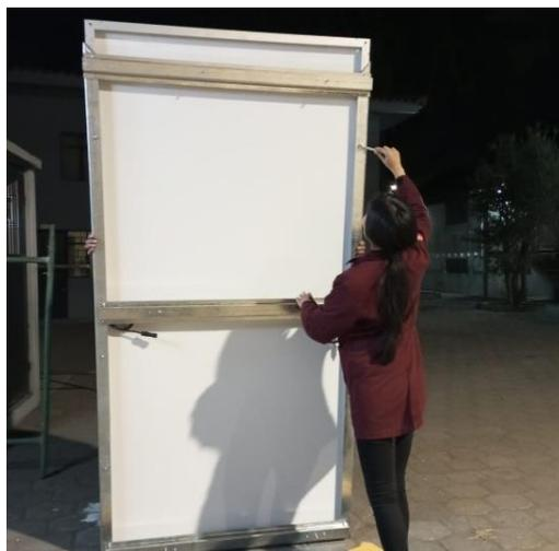
**Ilustración 4-3:** Acople del panel solar a la base
