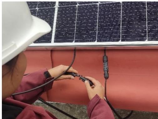
**Ilustración 3-7:** Colocación de conectores MC4
