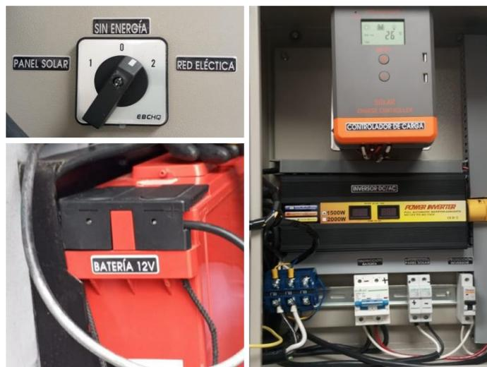
**Ilustración 4-9:** Identificación de componentes de sistema
