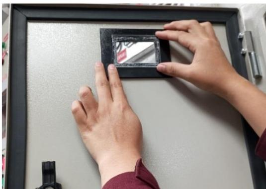
**Ilustración 4-7:** Ventana de visualización en el tablero eléctrico
