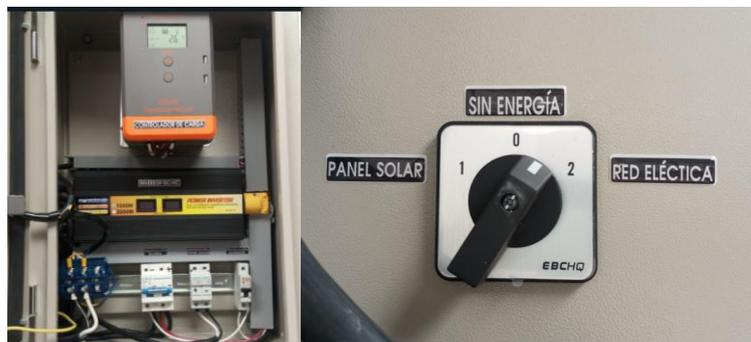
**Ilustración 3-20:** Señalética en el tablero del sistema fotovoltaico
