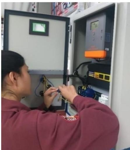
**Ilustración 4-6:** Conexión de la transferencia manual
