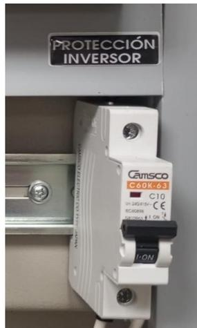
**Ilustración 3-13:** Protección eléctrica del inversor
