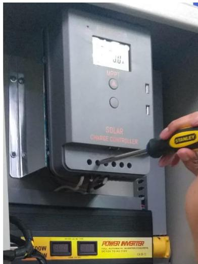
**Ilustración 3-15:** Conexiones en el controlador de carga
