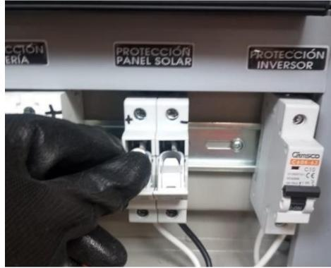
**Ilustración 3-8:** Instalación de protección eléctrica del panel solar
