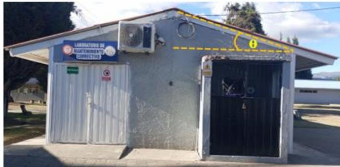
**Ilustración 3-2:** Inclinación de la cubierta del Laboratorio
