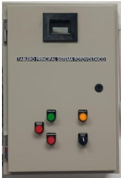
**Ilustración 4-8:** Configuración de luces piloto
