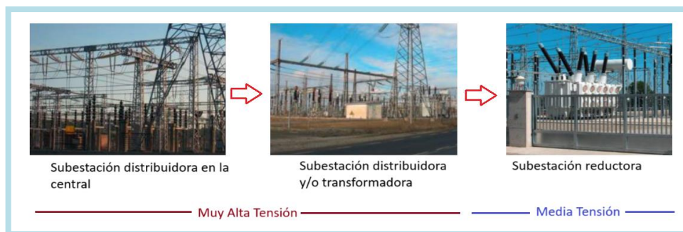
Ilustración 2-1: Subestaciones para la distribución de media tensión eléctrica.
