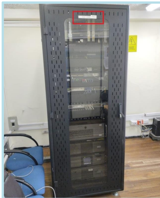
Ilustración 3-2: Rack SCADA.
