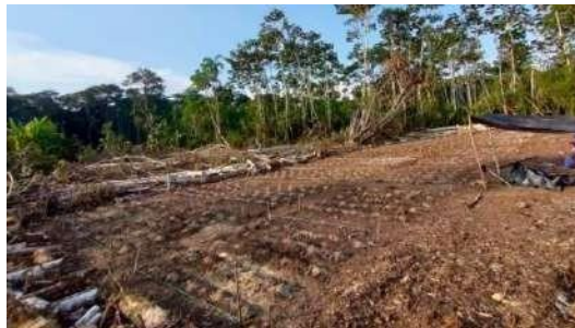
Ilustración 3-2: Preparación del terreno
