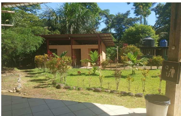
Ilustración 4-21: Baterías Sanitarias del centro turístico
