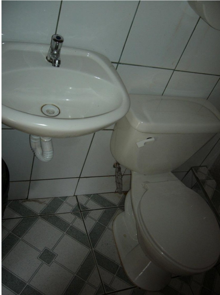
Anexo N° 42: Fotografía de instalación de grifos
