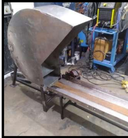
Ilustración 3-59: Construcción de Banda Transportadora Realizado por: Lasluisa D., Lozada C.,2023
