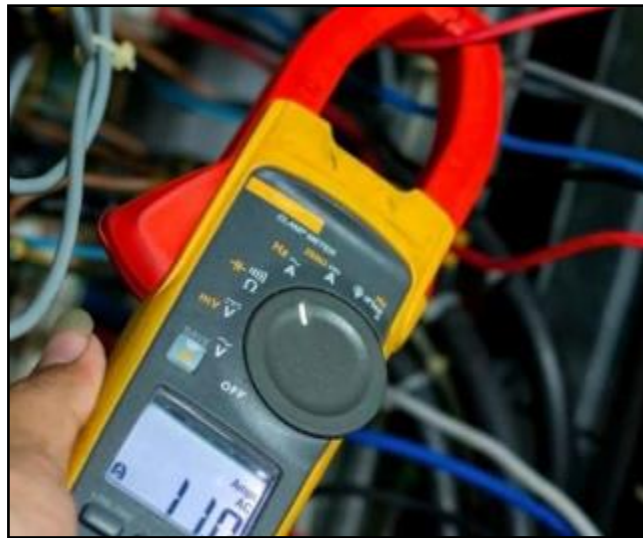
Figura 18-2: Pinza amperimétrica para el balance de cargas. Realizado por: Tamami Carlos, 2020
