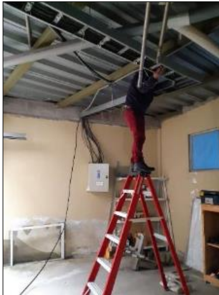
Figura 17-2: Cambio de cables eléctricos en el área de sellado. Realizado por: Tamami Carlos, 2020
