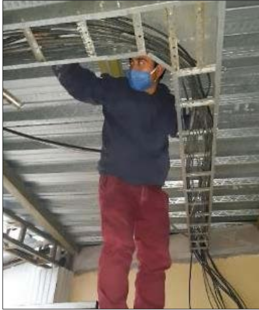
Figura 11-2: Cambio de cables eléctricos del tablero principal Realizado por: Tamami Carlos, 2020
