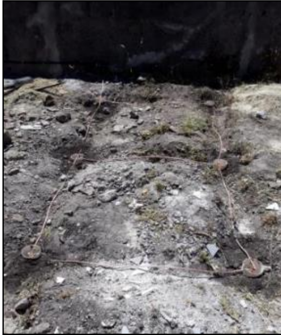
Figura 25-2: Mallado con el alambre de cobre Realizado por: Tamami Carlos, 2020
