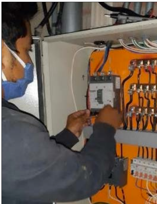
Figura 9-2: Cambio del interruptor termomagnético principal Realizado por: Tamami Carlos, 2020
