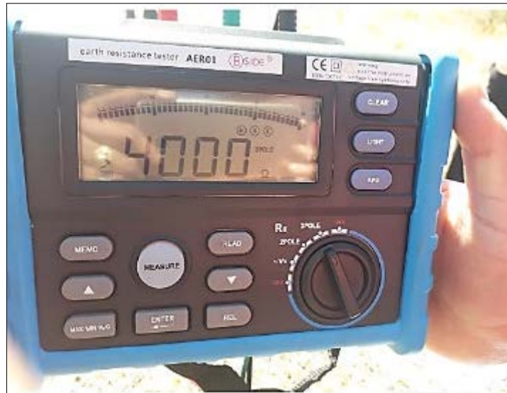
Figura 21-2: Medición de la resistividad con teluometro Realizado por: Tamami Carlos, 2020
