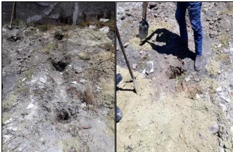
Figura 22-2: Excavación para varillas copperweld Realizado por: Tamami Carlos, 2020
