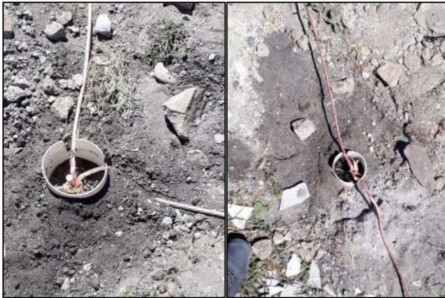
Figura 26-2: Conexión de cada varilla con el alambre de cobre Realizado por: Tamami Carlos, 2020
