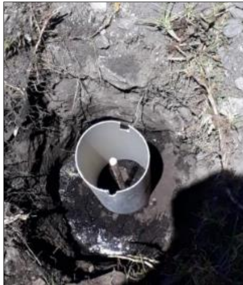
Figura 24-2: Mezcla de tierra negra con electrolitos Realizado por: Tamami Carlos, 2020
