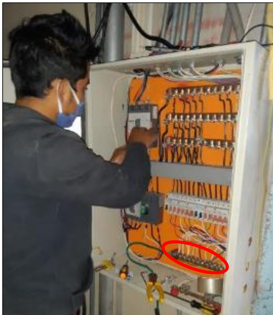
Figura 12-2: Montaje barras eléctricas para neutro Realizado por: Tamami Carlos, 2020
