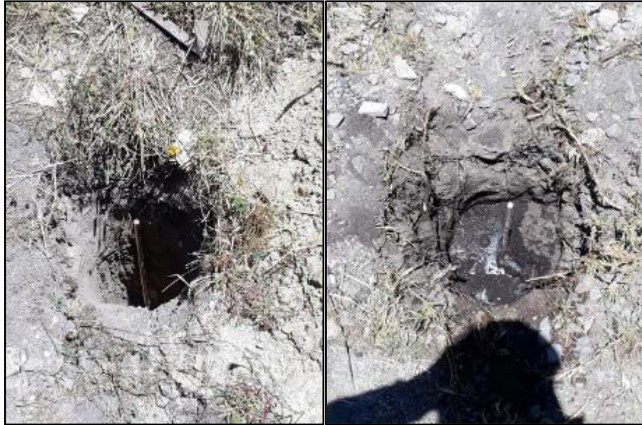
Figura 23-2: Colocación de las varillas copperweld Realizado por: Tamami Carlos, 2020
