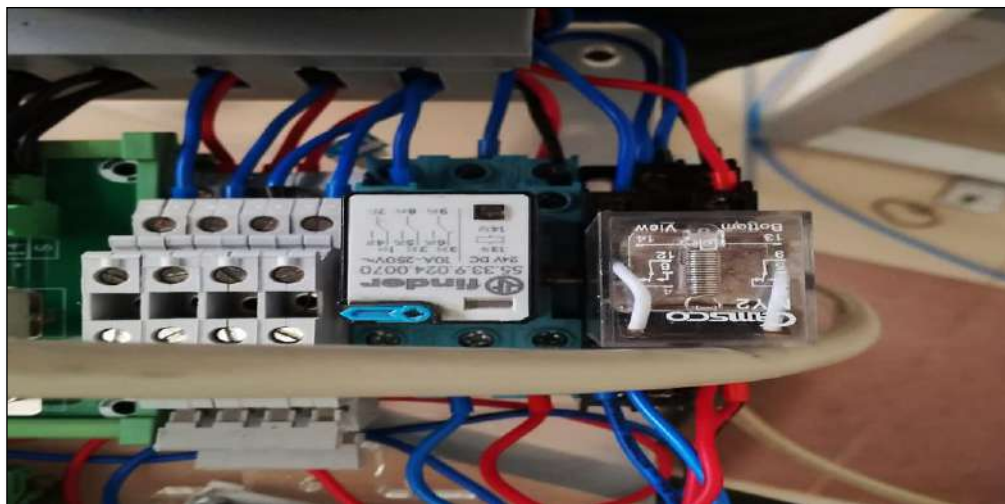
Ilustración 3-35: Relé de potencia a 24 VDC.
