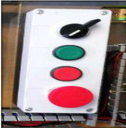
Ilustración 3-16: Pulsadores de inicio, paro y seta de emergencia
