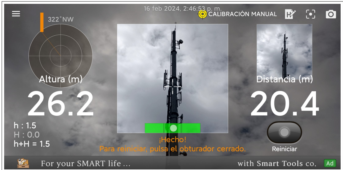
Ilustración 3-3: Medición de altura de la estación base 2 con Smart Measure Realizado por: Sanga C., 2024
