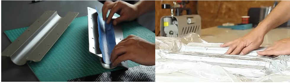
Ilustración 2-28: Aplicación de las capas de fibra de carbono y curado al vacío.
