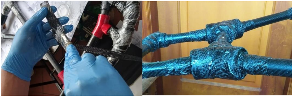
Ilustración 4-4: Aplicación de capas de tela de fibra de carbono.
