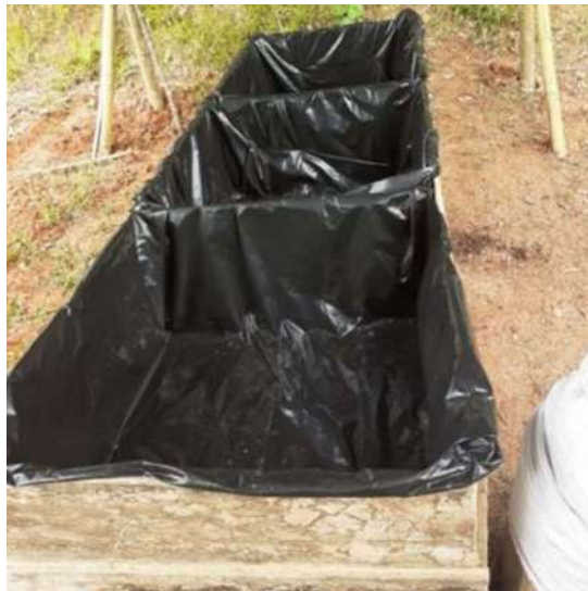
Ilustración 11-3: Construcción de pilas
