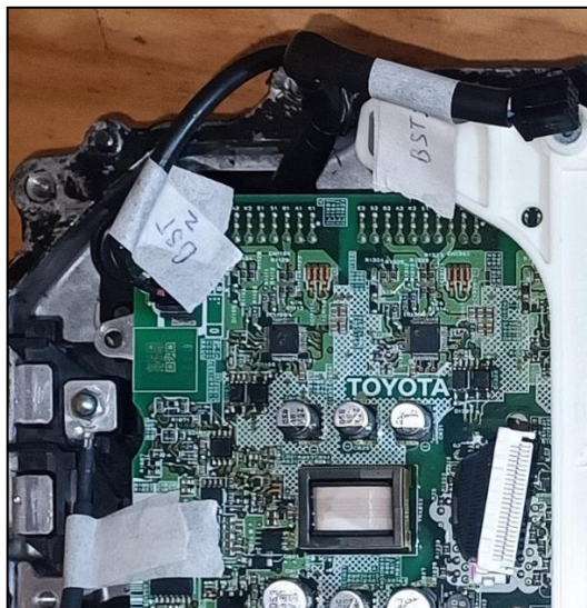
Ilustración 3-5: Etiquetado de cables
