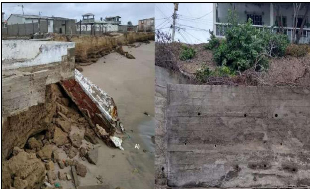
**Figura 7-1:** Efectos de la erosión en el frente urbano costero. A) Vivienda colapsada producto del peso de la estructura y la debilitación por parte de los factores erosivos. B) Muro de prevención, construido sobre la pared de un talud el cual está bajo los efectos.
