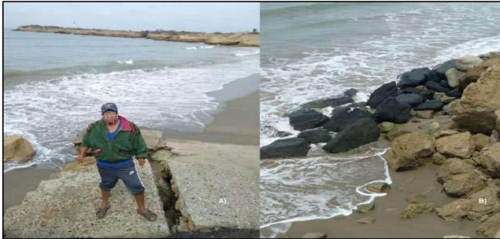
**Figura 1-4:** Destrucción del muro de protección por efectos fuertes efectos erosivos
