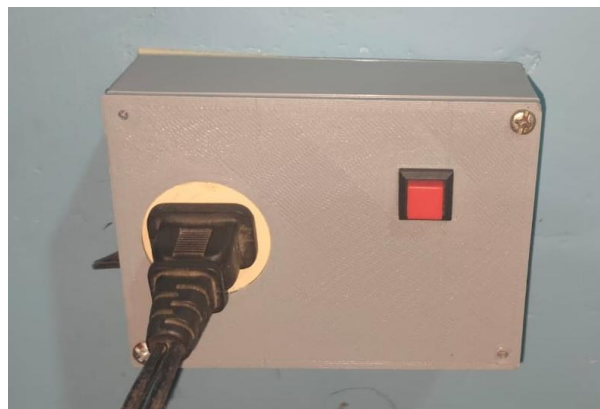
Figura26-2: Instalación del tomacorriente para controlar el radio.
