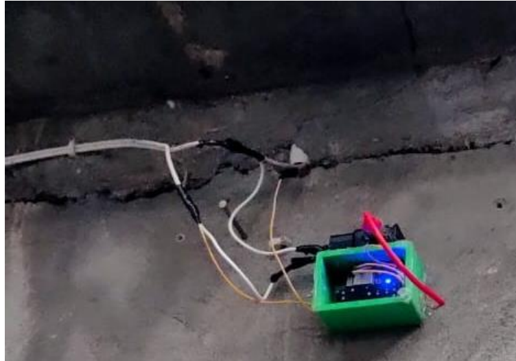
Figura29-2: Instalación del detector de movimiento en la bodega.
