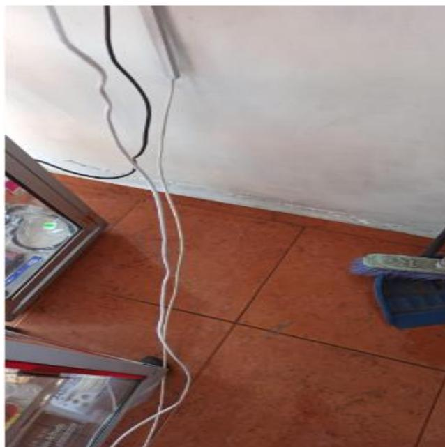
**Ilustración 4-6:** Cables sueltos en la farmacia
