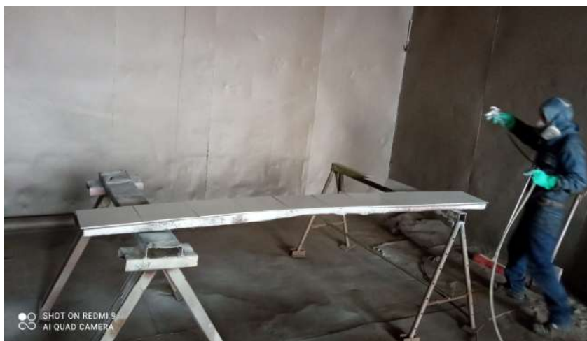
Ilustración 3-24: Aplicación del sandblasting
