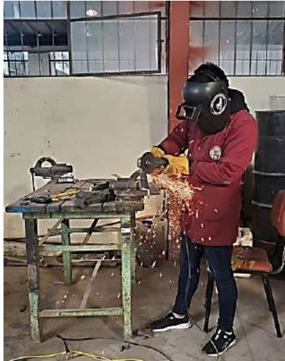
Ilustración 3-6: Corte del acero estructural
