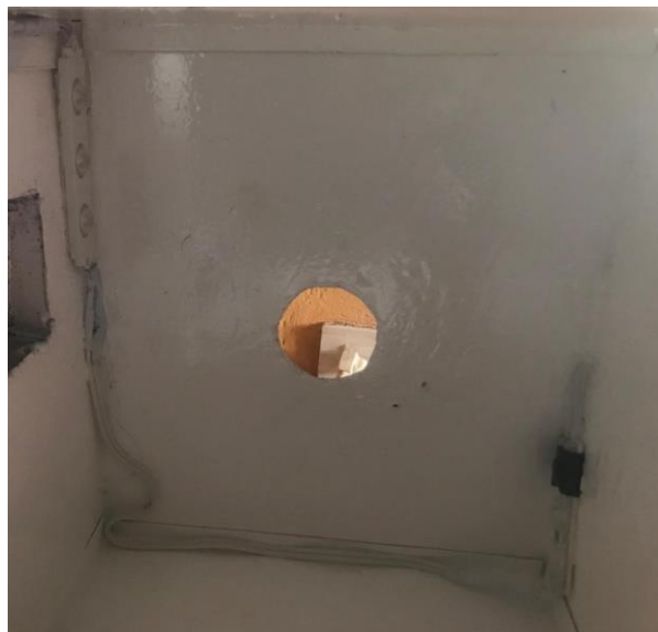
Ilustración 10-3: Instalación de módulos led en la cabina oscura.
