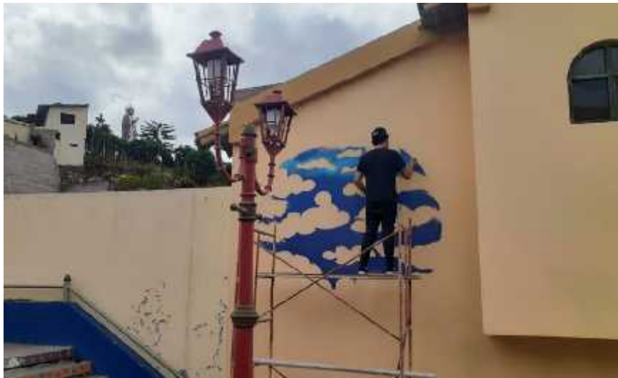
Figura 12-3: Intervención en muro Realizado por: Guevara Juan, Chamba Angel, 2021.
