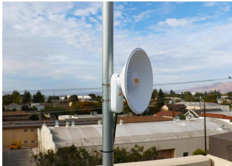
**Figura 9-3.** Antena y radio mimosa instalado.
