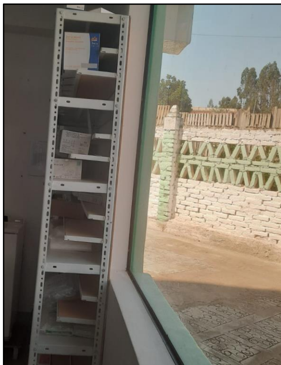
Ilustración 4-8: Estanterías pegadas a la pared
