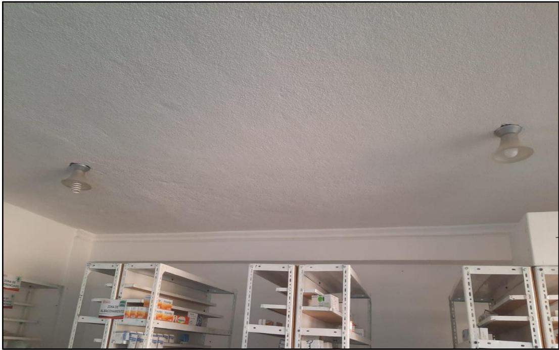
Ilustración 4-3: Superficie del techo del establecimiento: Plana y estucada
