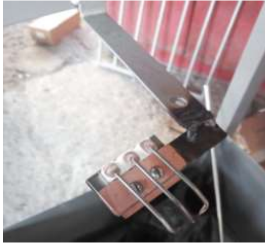
Ilustración 3-50: Instalación del chispero
