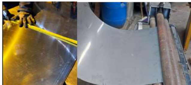
Ilustración 3-37: Construcción del recipiente a presión.
