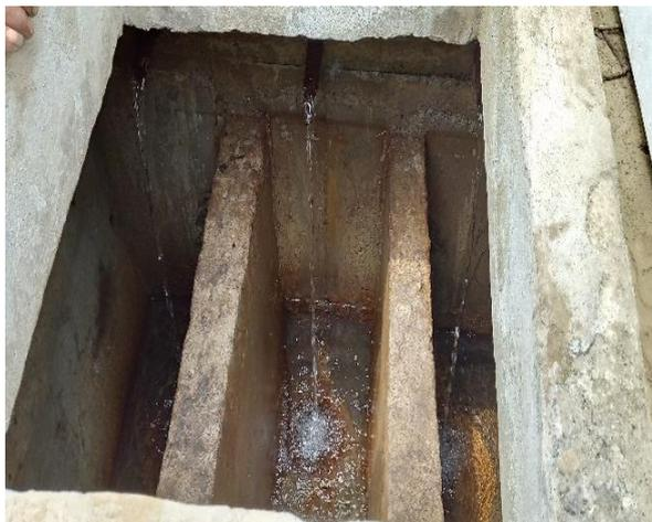
**Ilustración 3-8:** Tanque de distribución
