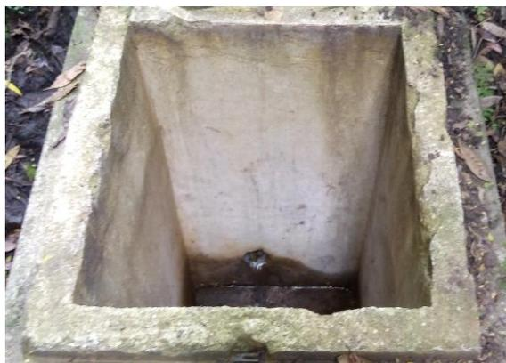
**Ilustración 3-5:** Tanque construido para la vertiente.
