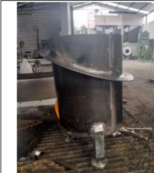
Construcción del tanque
