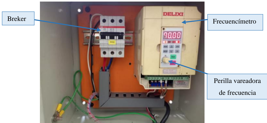
Ilustración 5-4: Parte interior del panel de control de la celda de flotación. Fuente: Godoy, L., Valle, A., 2022.
