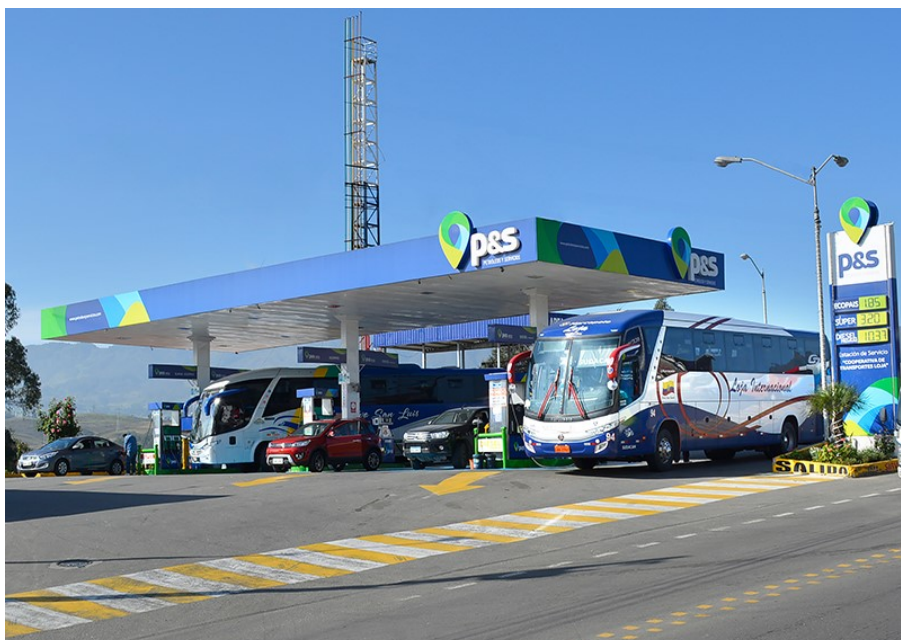
Figura 9-4: Bomba de Aprovisionamiento de Combustible Cooperativa Loja Internacional. Fuente: Estación de Servicios Cooperativa Loja Realizado por: Edwin Jami V.
