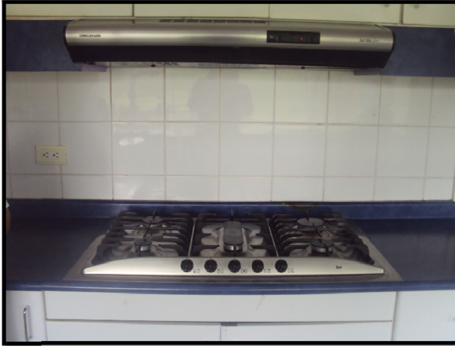
FOTOGRAFIA No. 1. SALA DE PREPARACIÓN O DE COCCIÓN DE PRODUCTOS CÁRNICOS.
