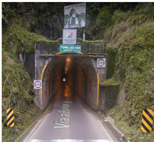
Figura 26-3: Imagen Túnel unidireccional Agoyán.
