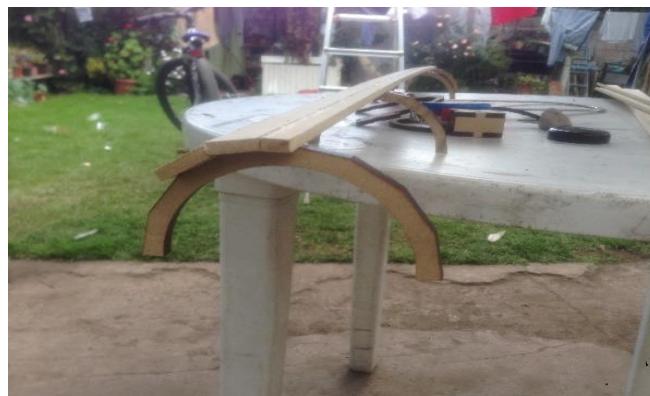
Figura 40-3. Unión de piezas superiores de la cubierta del túnel. Realizado por: López, 2020
