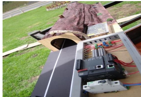
Figura 82-3. Resultado Final túnel 1.
