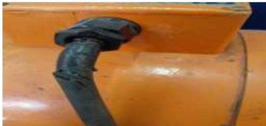
**Ilustración 3-10:** Cable del motor al variador de frecuencia estado inicial
