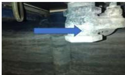
**Ilustración 3-8:** Válvula de descarga estado inicial
