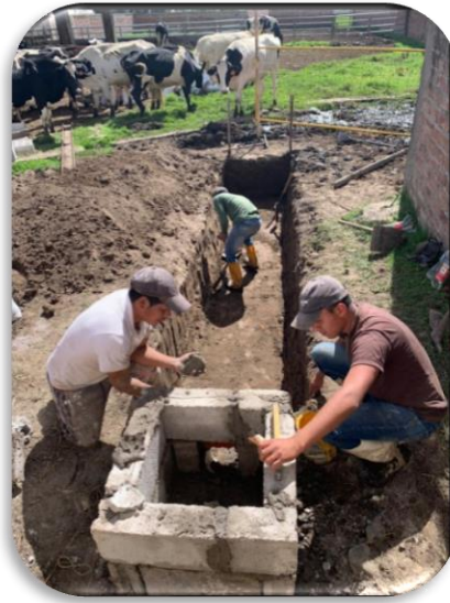
Ilustración 9-3: Construcción de caja de entrada.
