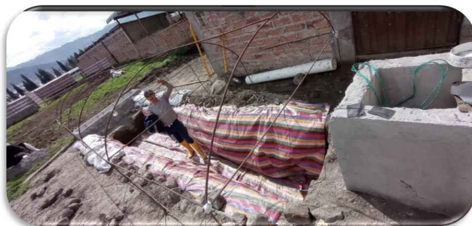
Ilustración 14-3: Instalación de estructura en zanja.
