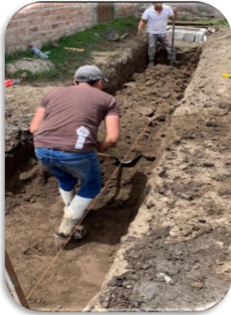
Ilustración 8-3: Excavación manual a la izquierda y retirada de material a la derecha
