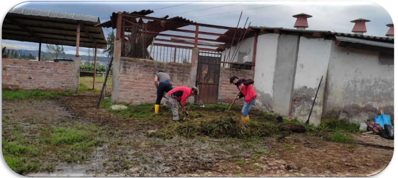
Ilustración 7-3: Preparación manual del terreno
