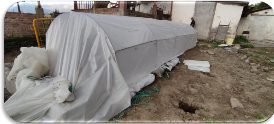
Ilustración 15-3: Instalación de cubierta superior.
