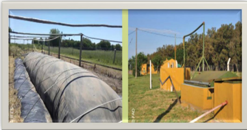
Ilustración 3-2 Biodigestor tubular de polietileno a la izquierda y Biodigestor chino a la derecha.
