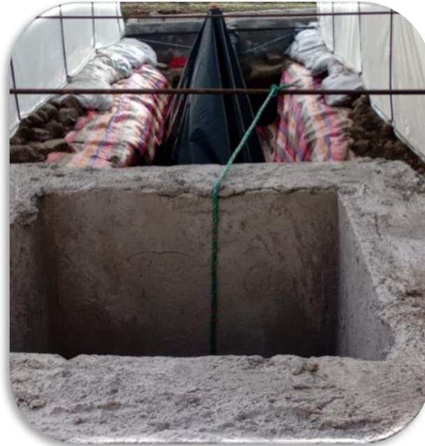
Ilustración 12-3: Instalación del plástico reactor dentro de la zanja
