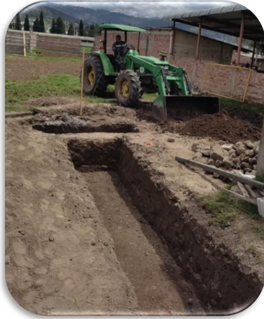
Ilustración 8-3: Excavación manual a la izquierda y retirada de material a la derecha
