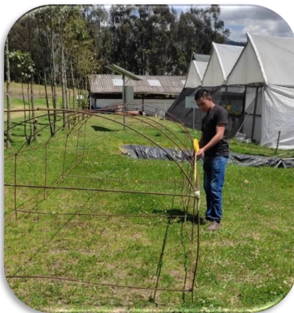
Ilustración 13-3 Medición de estructura metálica de invernadero
