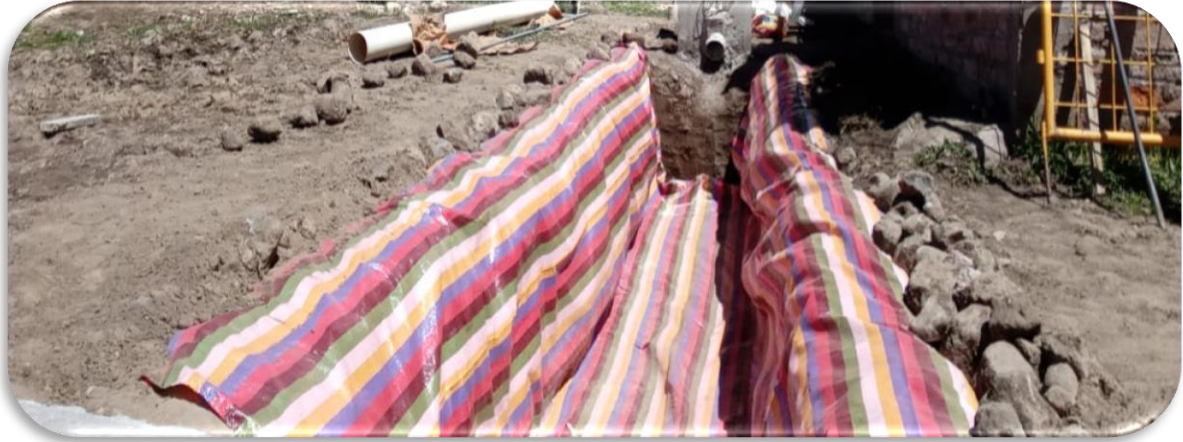
Ilustración 10-3: Finalización de instalación de cubierta inferior
