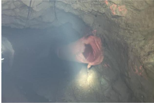
**Ilustración 25-4:** Mangas de ventilación mal colocadas
