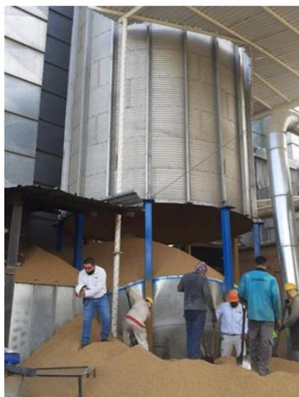
**Figura 9-2:** Falla por colapso de la tolva de un silo
