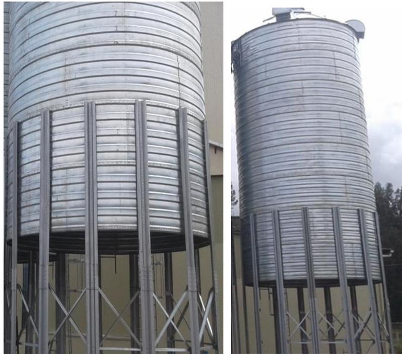
**Figura 4-A:** Armado del silo con capacidad de 100 toneladas
