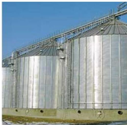
**Figura 3-2:** Silos de metal de fondo plano
