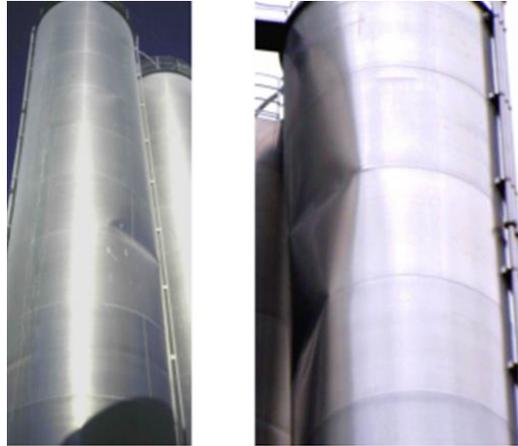
**Figura 8-2:** Falla en silos de descarga excéntrica
