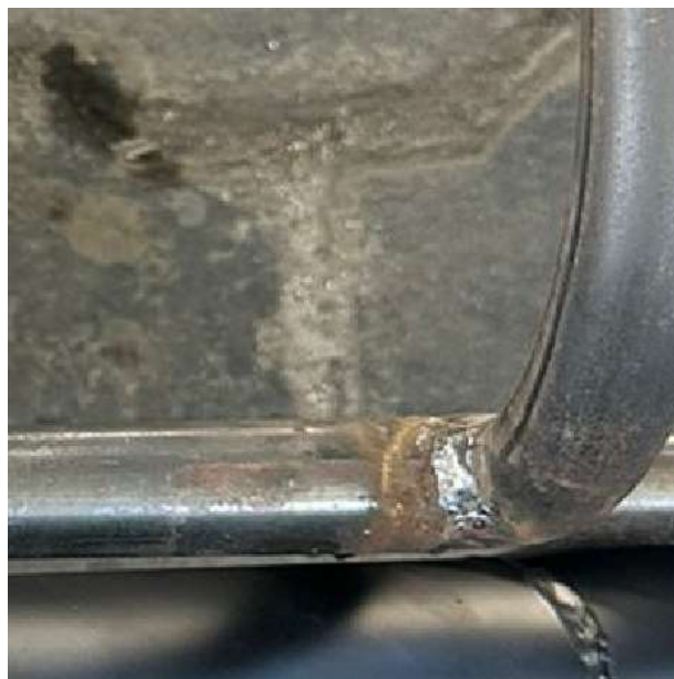
Ilustración 3-37: Cordón de soldadura.
