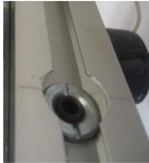
**Figura IV.36: Colocación del bulón**
