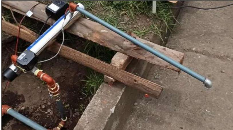
**Ilustración 23-4:** Conexión de la cámara de desinfección ultravioleta
