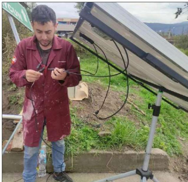
**Ilustración 20-4:** Conexión de los conectores macho y hembra de los paneles
