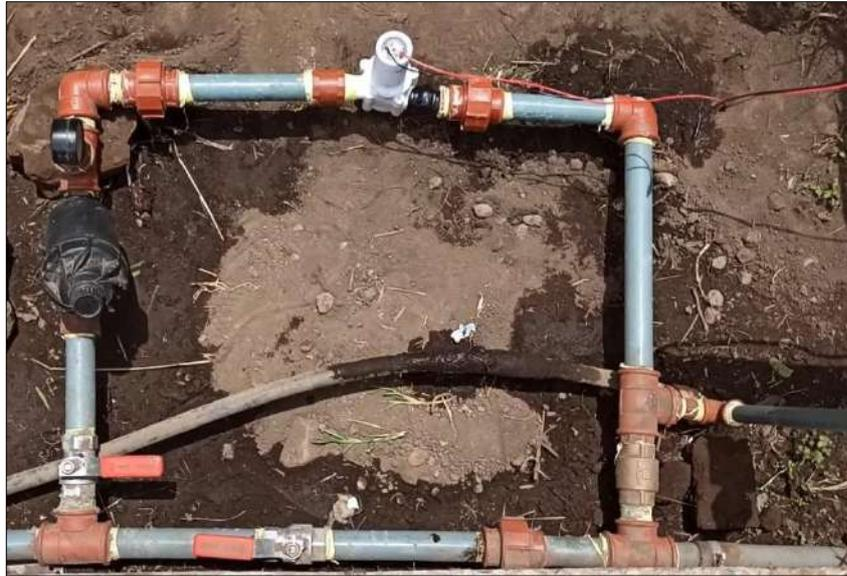
**Ilustración 22-4:** Instalación de baipás en la tubería principal
