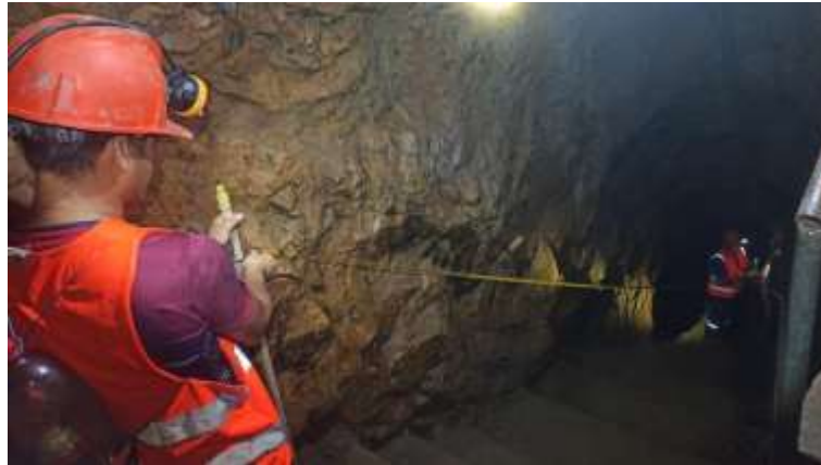
Ilustración 18-4: Levantamiento de escaleras
