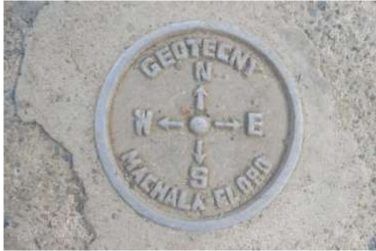
Ilustración 9-4: Hito geotécnico de la mina Divino Niño de Jesús
