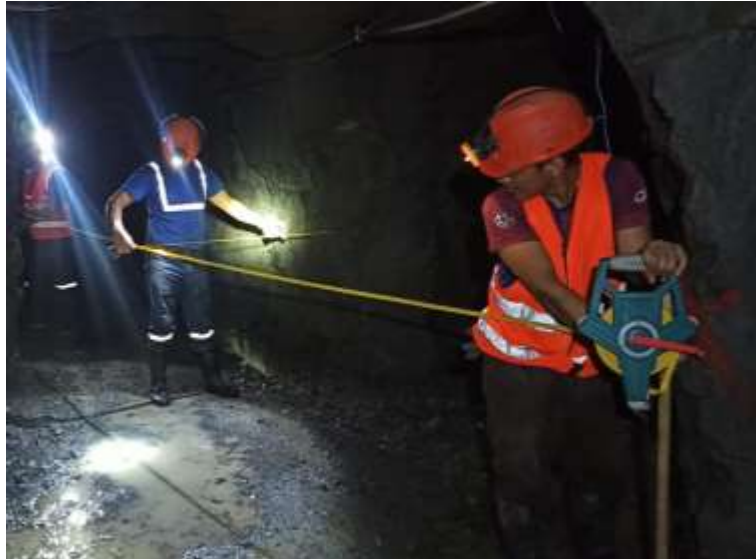
Ilustración 16-4: Medición de la galería de exploración en el nivel 4
