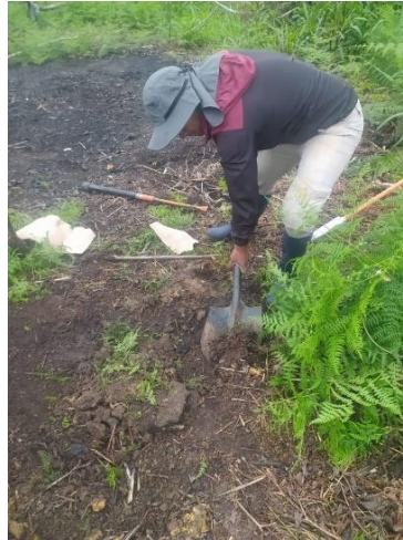
Ilustración 7-3: Relleno de orificio del sondeo
