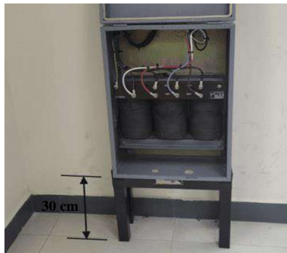
Ilustración 7-4: Montaje del autotransformador.
