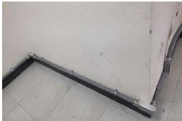
Ilustración 3-4: Montaje de tubería conduit.
