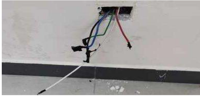
Ilustración 5-3: Adición del conductor blanco.
