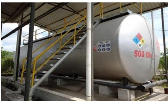
**Ilustración 1-2:** Tanque de almacenamiento de diésel industrial
