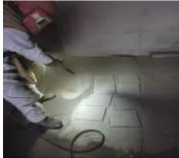
**Figura 3-2:** Sandblasting a las placas de acero
