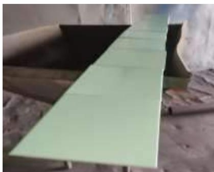
**Figura 16-2:** Aplicación del acabado o segunda capa
