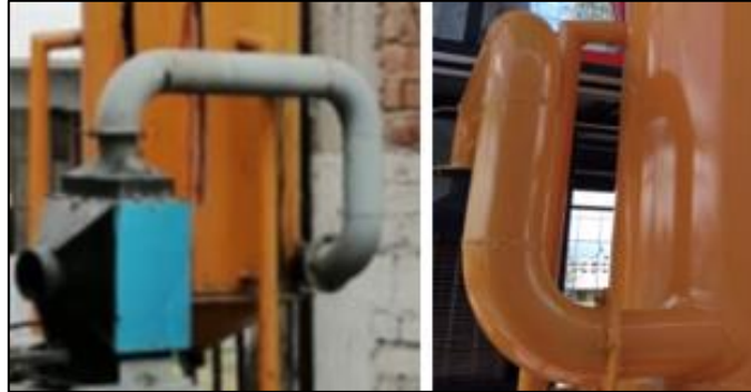
Figura 3-4: Habilitación línea conducción intercambiador de calor-Mangas
