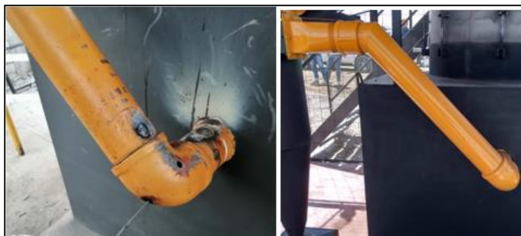
Figura 1-4: Habilitación de la línea de conducción a ciclón
