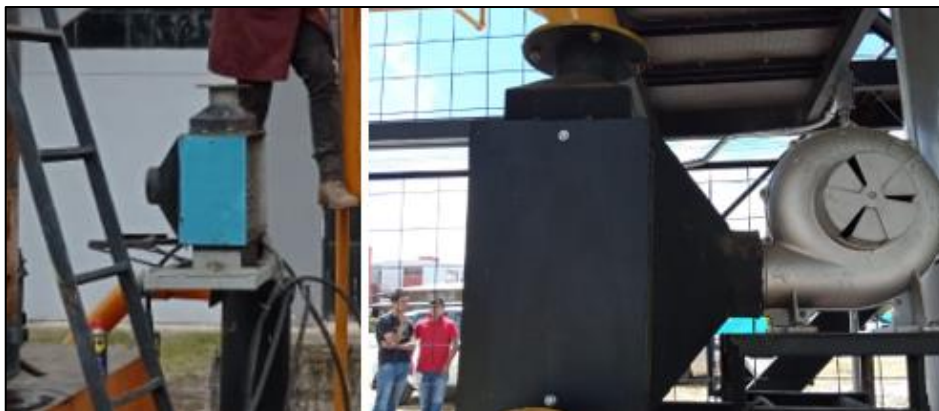
Figura 6-4: Habilitación del intercambiador de calor compacto
