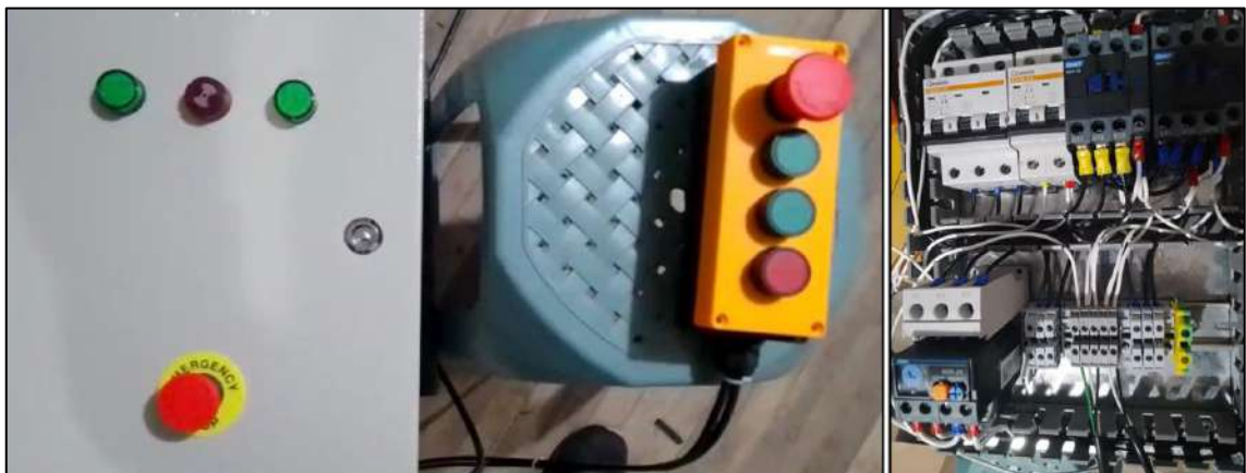
Ilustración 55-3: Armado del tablero eléctrico con el mando a distancia
