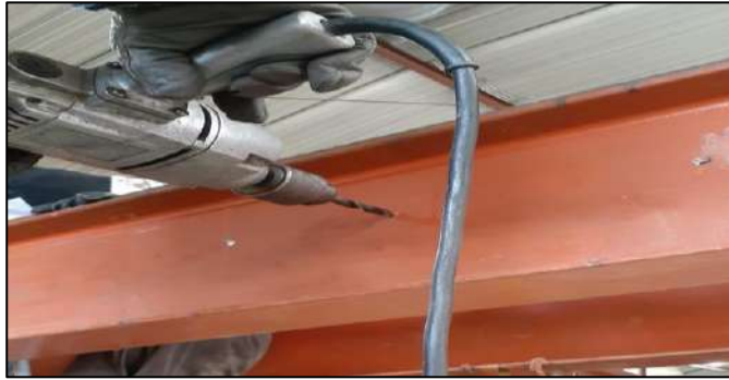
Ilustración 48-3: Perforado de la viga del puente grúa
