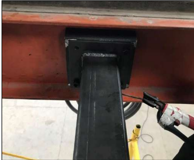
Ilustración 24-4: Adecuaciones en los arriostramientos
