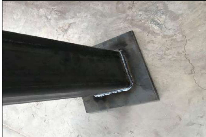
Ilustración 20-4: Soldadura MIG del arriostramiento
