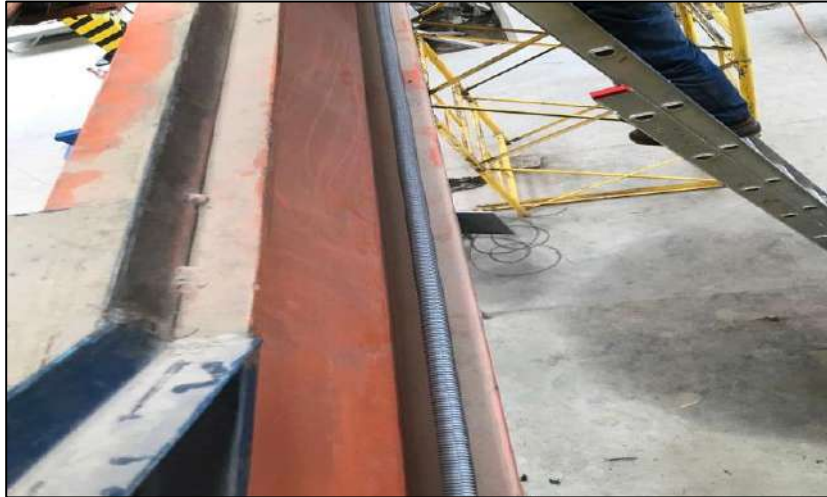
Ilustración 60-3: Colocación del cable en el perfil IPN del puente grúa
