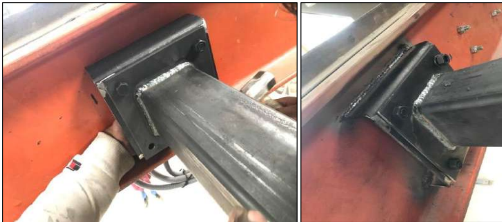
Ilustración 23-4: Montaje de los arriostramientos desmontables
