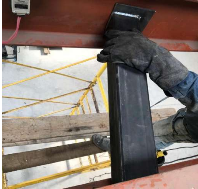
Ilustración 22-4: Montaje de los arriostramientos fijos
