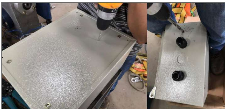
Ilustración 57-3: Adecuaciones a la caja eléctrica para su anclaje
