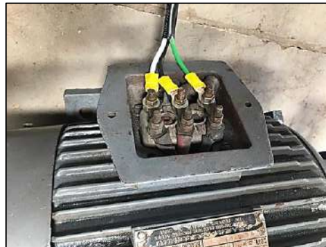
Ilustración 61-3: Conexión del motor
