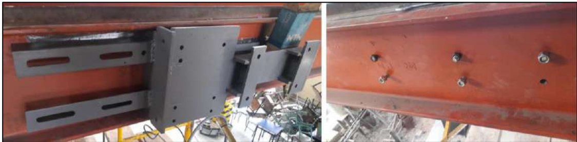
Ilustración 49-3: Montaje del bastidor en el alma del puente grúa
