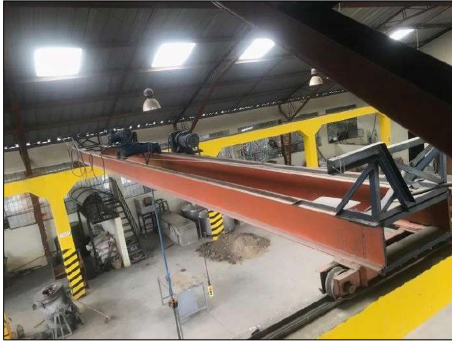
Ilustración 8-4: Vigas que conforman el puente grúa
