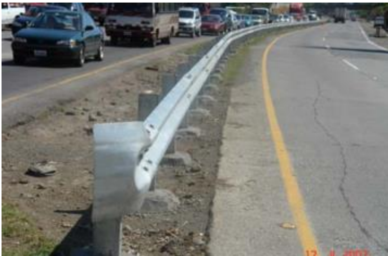
Figura 5-1. Barrera de contención con terminación cola de pez.
