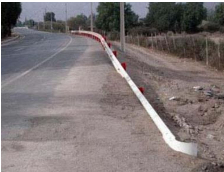
Figura 6-1. Abatimiento de terminación de barrera de contención.
