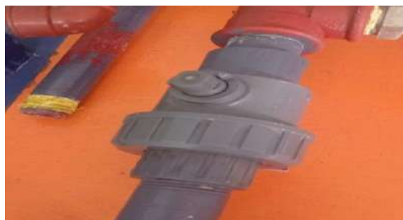
Ilustración 12-3: Válvula tipo de una universal
