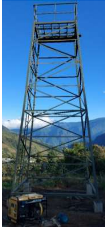
Ilustración 14-4: Estructura metálica de la torre
