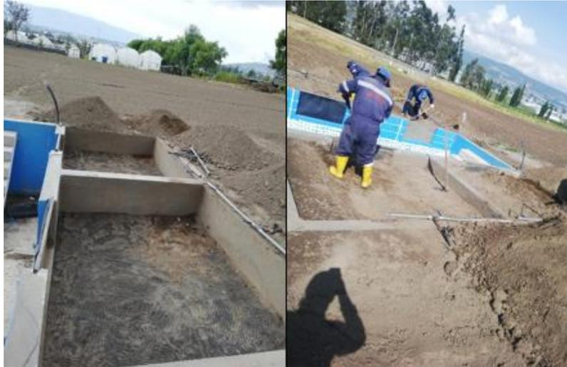
**Figura 2-2.** Mantenimiento de los lisímetros y compactación del suelo
