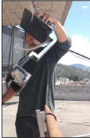
Figura 16-3: Aplicación de protección anticorrosiva y pintura del pedestal
