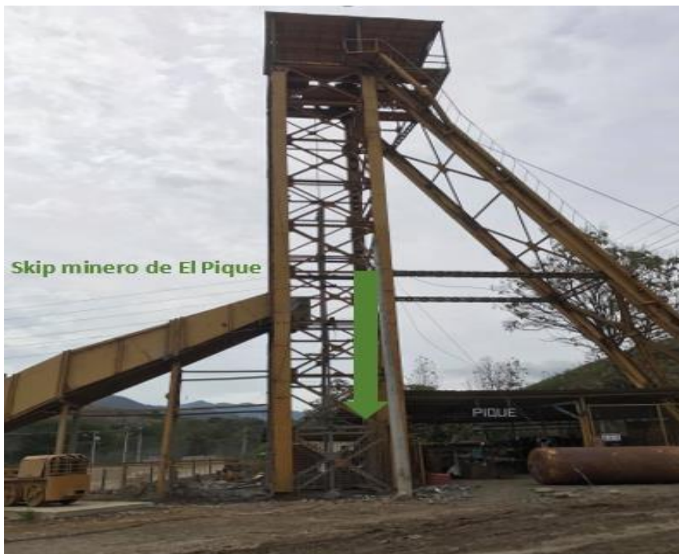
Figura 10-4: Labor de acceso a la mina El Pique
