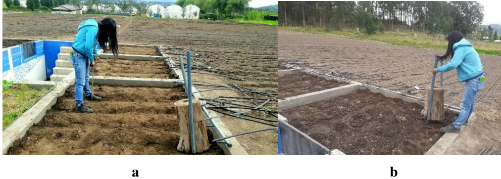
Figura 7-2. a) Verificación de la compactación, b) Compactación del suelo
