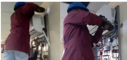
**Figura 36-3:** Instalación de la unidad interior
