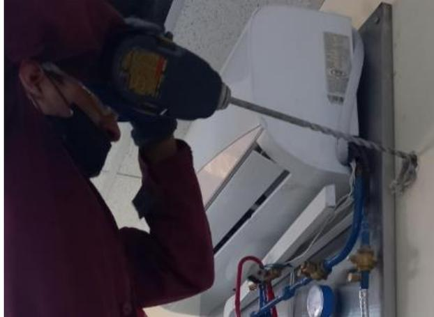
**Figura 20-3:** Colocación de la base de Split
