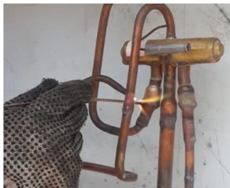
**Figura 26-3:** Soldadura de la válvula de 4 vías
