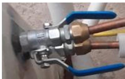
**Figura 24-3:** Colocación de válvulas de paso del condensador
