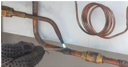
**Figura 28-3:** Soldadura de las válvulas check
