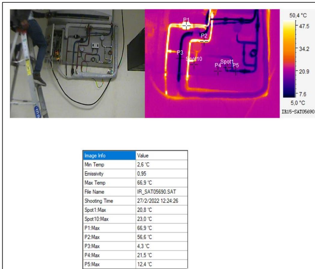
**Figura 7-4:** Termograma del ciclo de refrigeración
