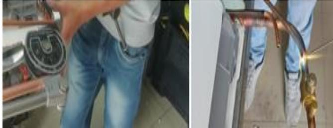
**Figura 22-3:** Soldadura de válvulas de paso
