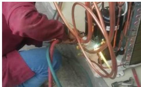
**Figura 23-3:** Colocación de válvulas de paso del compresor
