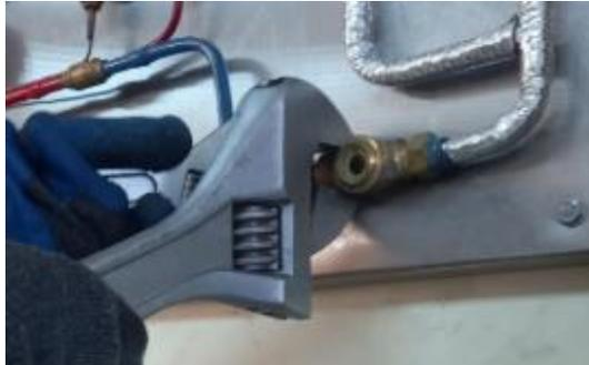
**Figura 30-3:** Colocación del visor
