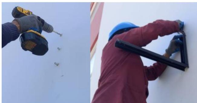
**Figura 35-3:** Instalación de la unidad condensadora
