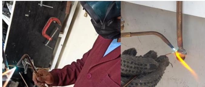
**Figura 25-3:** Soldadura de conexiones
