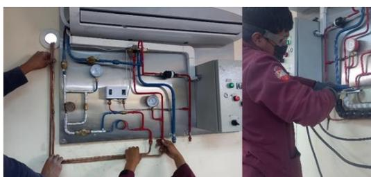
**Figura 37-3:** Instalación del circuito mecánico
