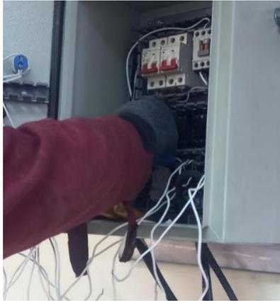
**Figura 33-3:** Colocación de componentes del circuito de mando
