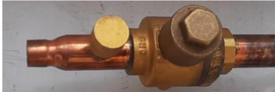
**Figura 8-3:** Válvula de paso
