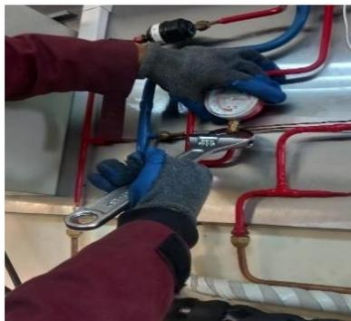
**Figura 29-3:** Colocación de manómetros
