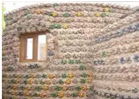
Figura 12 – 2: Fachada de una casa de botellas plásticas
