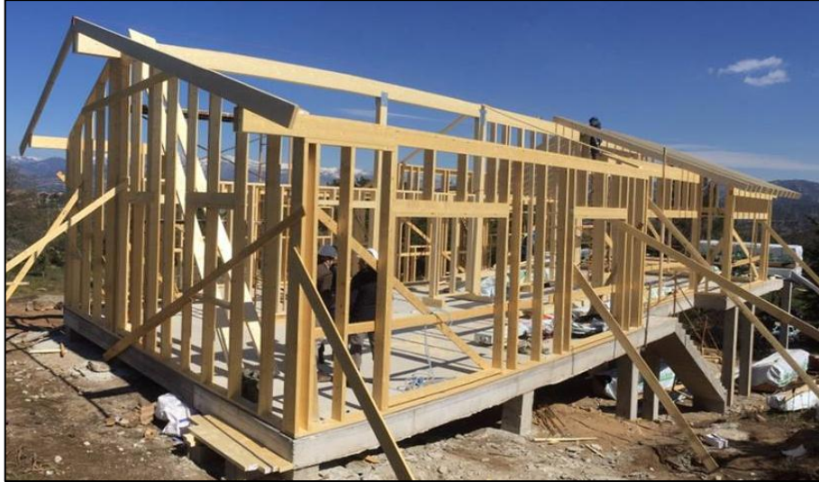
Figura 3-1: Estructura de madera para vivienda. Fuente: shorturl.at/cnuRX .2021
