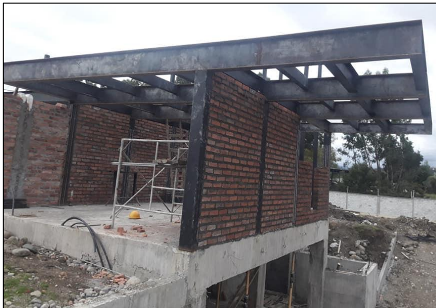
Figura 1-1: Estructuras metálicas para vivienda
